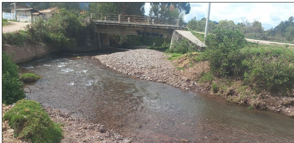
FIGURA N°01: TRAMO CRÍTICO EN EL RIO PITUMAYO, DISTRITO DE ANCAHUASI, PROVINCIA DE ANTA, SE APRECIA EL CAUCE COLMATADO.
